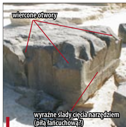
Fot. 8. Blok bazaltu z widocznymi śladami obróbki mechanicznej (cięcie i wiercenie)
