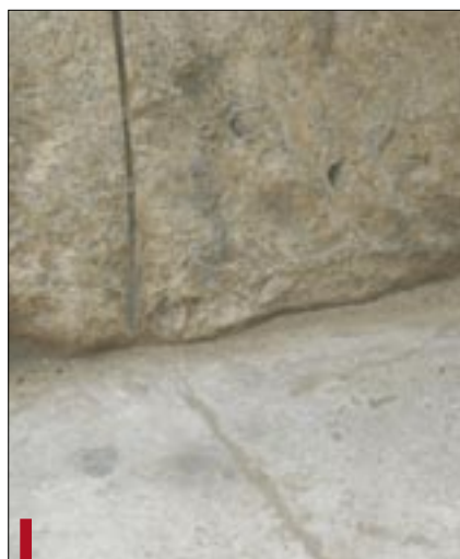
Fot. 3. Ślady poprawianego cięcia na styku bloków w podstawie piramidy Cheopsa
