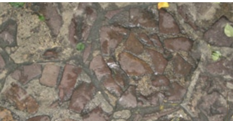
Fragment nawierzchni Nowego Kleparza w Krakowie z trylinki wykonanej na bazie porfiru z okolic Krzeszowic
